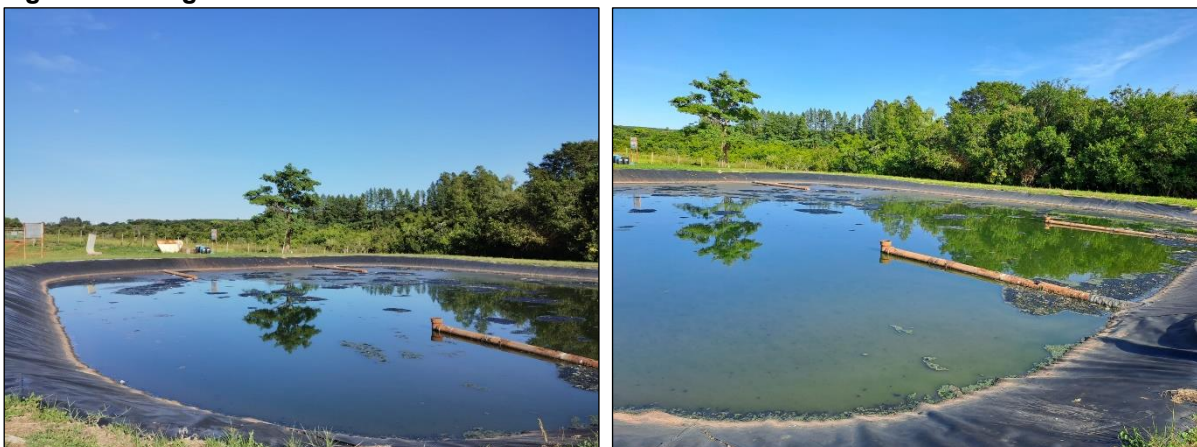
Figura 180: Lagoa Anaeróbia ETE Simonsen
