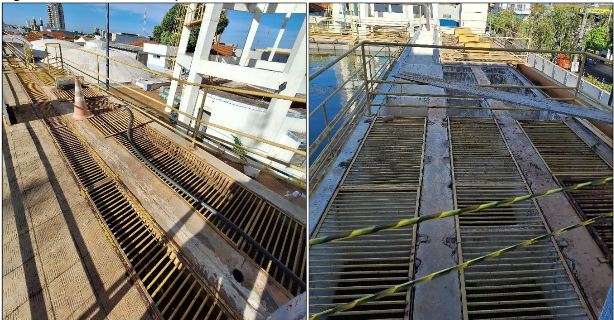
Figura 78: Área Externa Superior ETA
