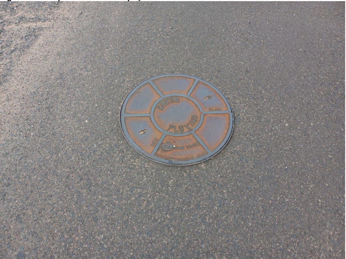
Figura 222: Tampa de acesso à um poço de Visita.
