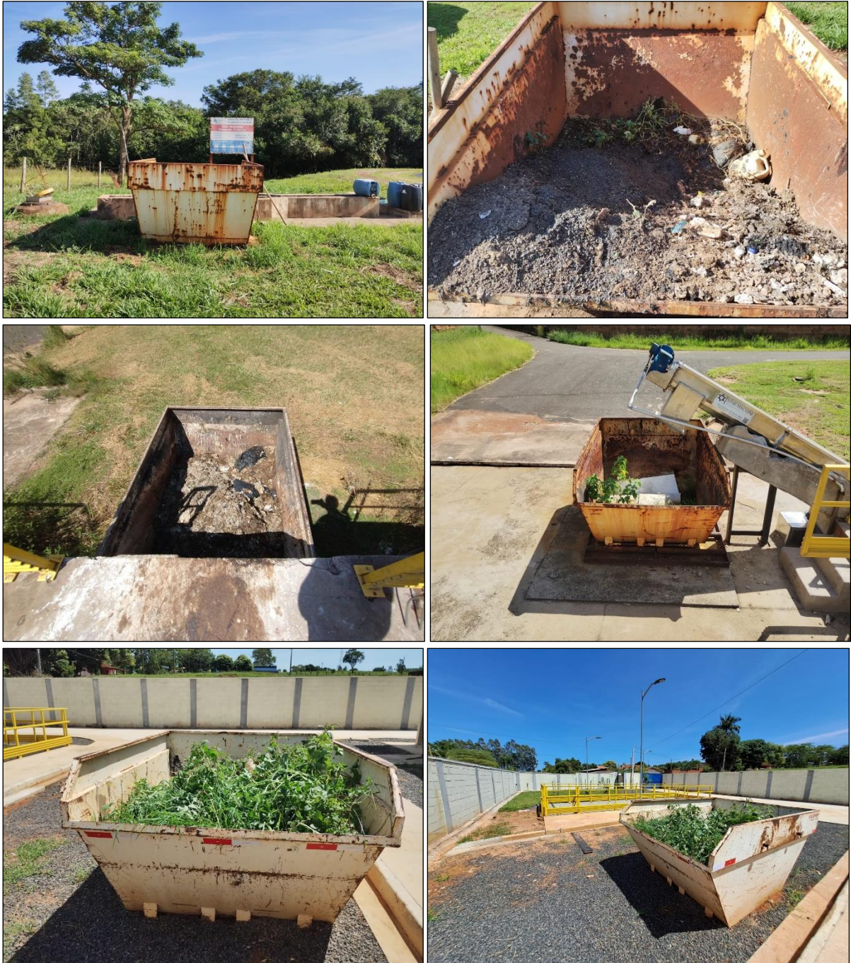
Figura 188: Caçambas metálicas para remoção dos resíduos gerados das ETE's
