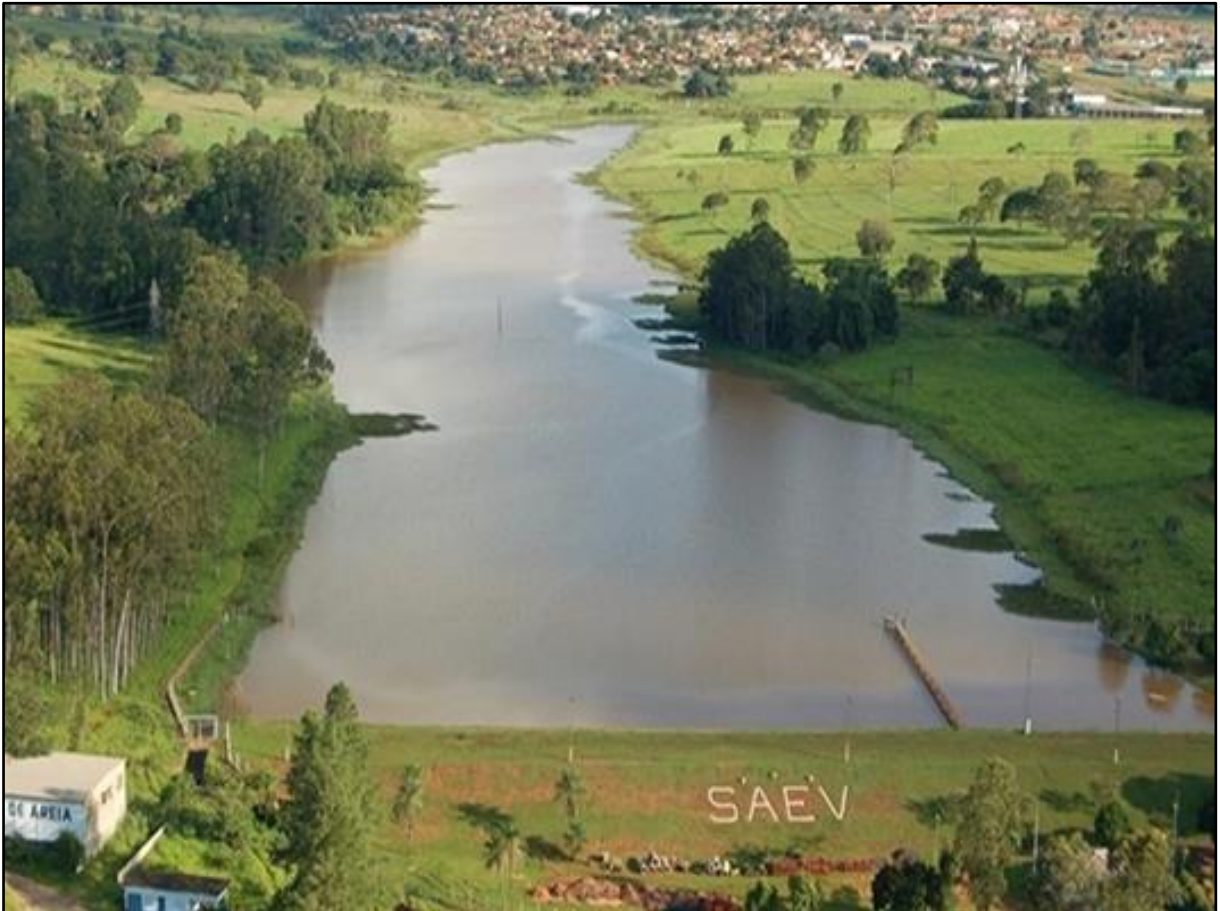
Figura 209: Represa de captação para abastecimento público
