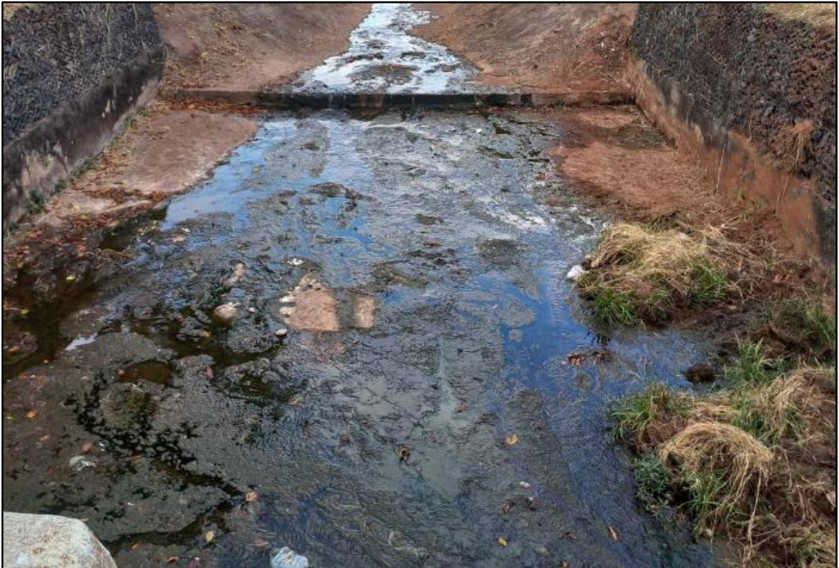
Figura 291: Trecho canalizado do córrego Boa Vista – Rua José Abdo
