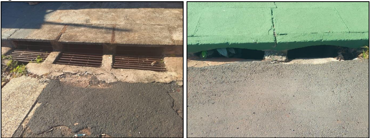
Figura 220: Bocas de lobo
