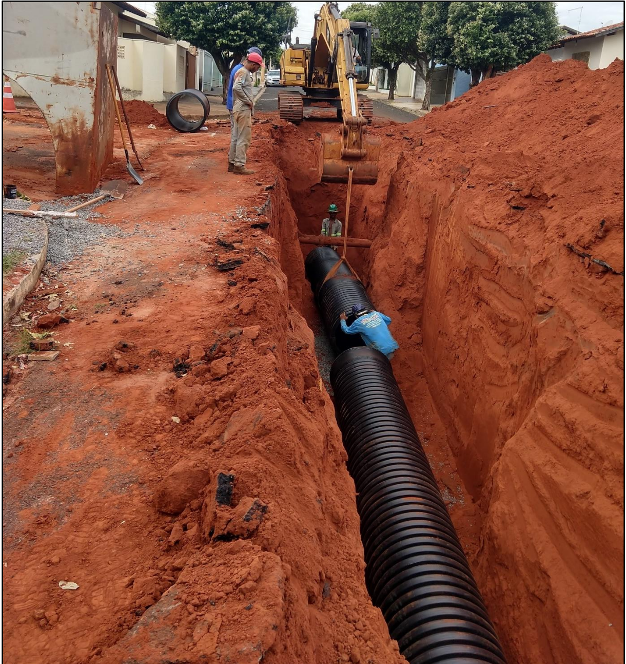
Figura 223: Tubo em PEAD corrugado utilizado para galerias de águas pluviais
