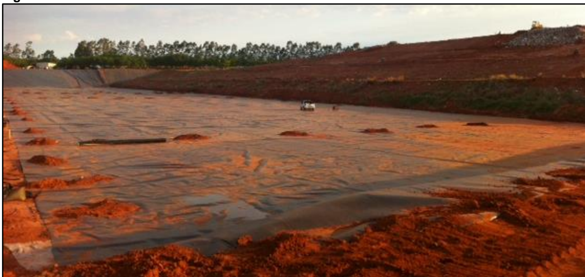
Figura 337: Aterro Sanitário localizado em Meridiano/SP
