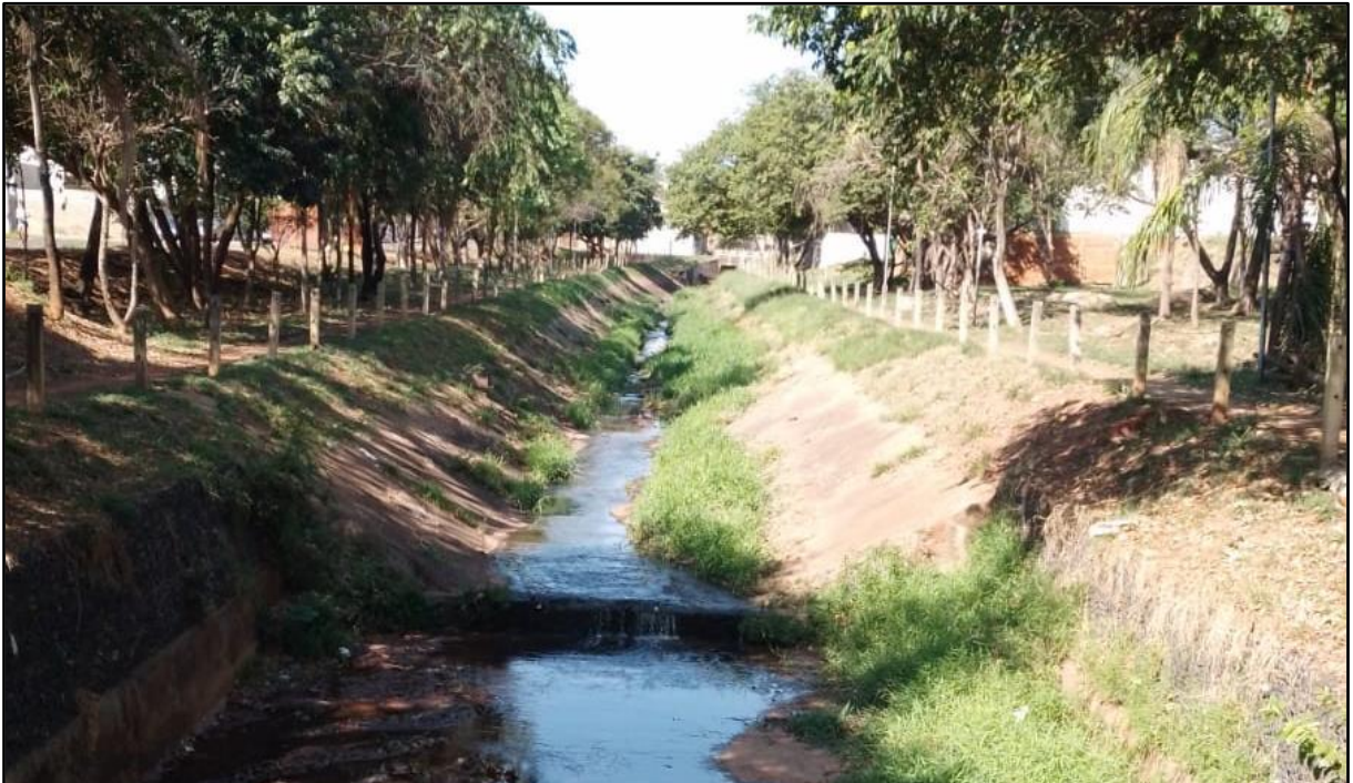
Figura 279: Córrego canalizado - Av. Prestes Maia até Rua Cavenagui
