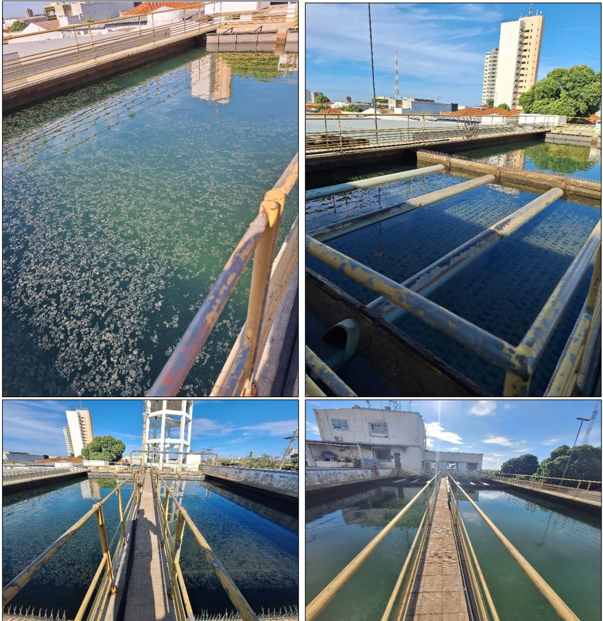
Figura 126 - Etapa de Floculação do Tratamento de Água
