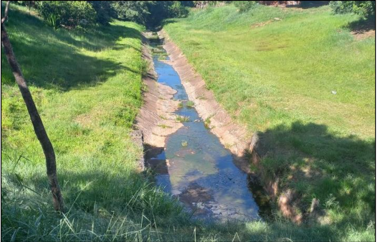
Figura 287: Córrego canalizado no Parque Chico Mendes
