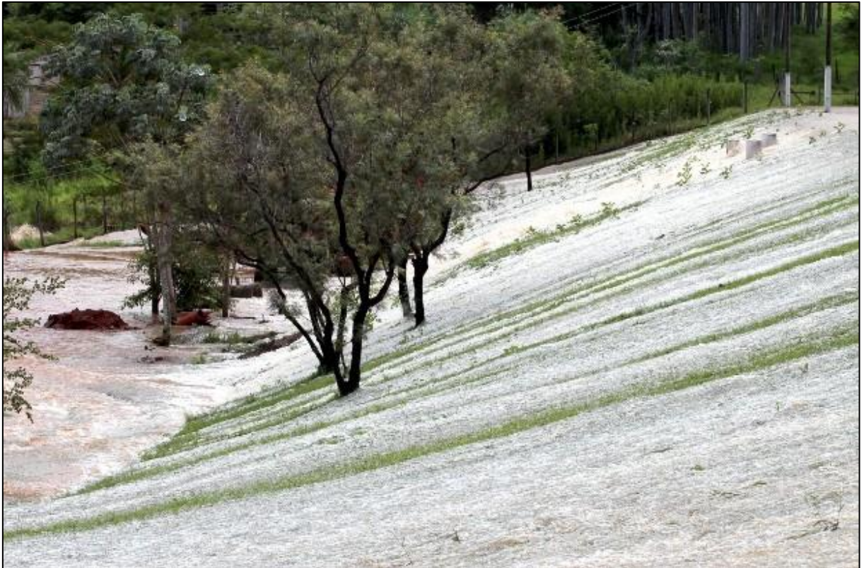
Figura 273: Transbordamento da Represa de Captação em 2014
