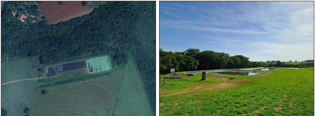
Figura 178: Vista da Estação de Tratamento de Esgoto do Distrito de Simonsen
