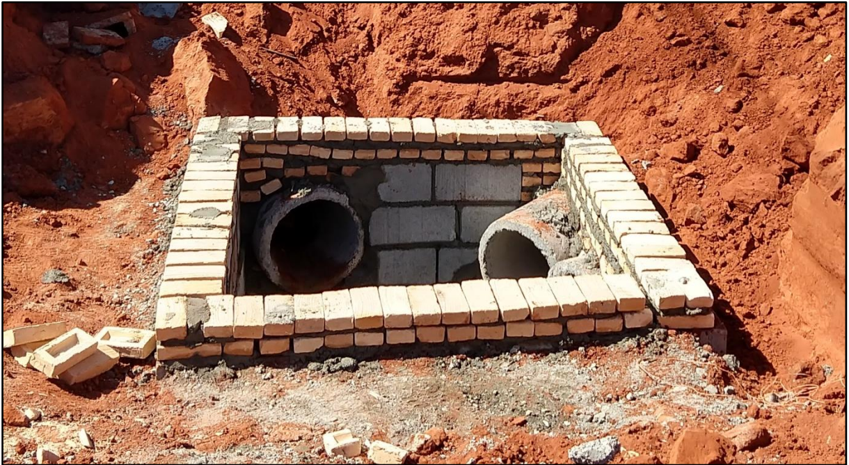
Figura 221: Fase construtiva de um poço de visita com detalhe dos condutos de ligação
