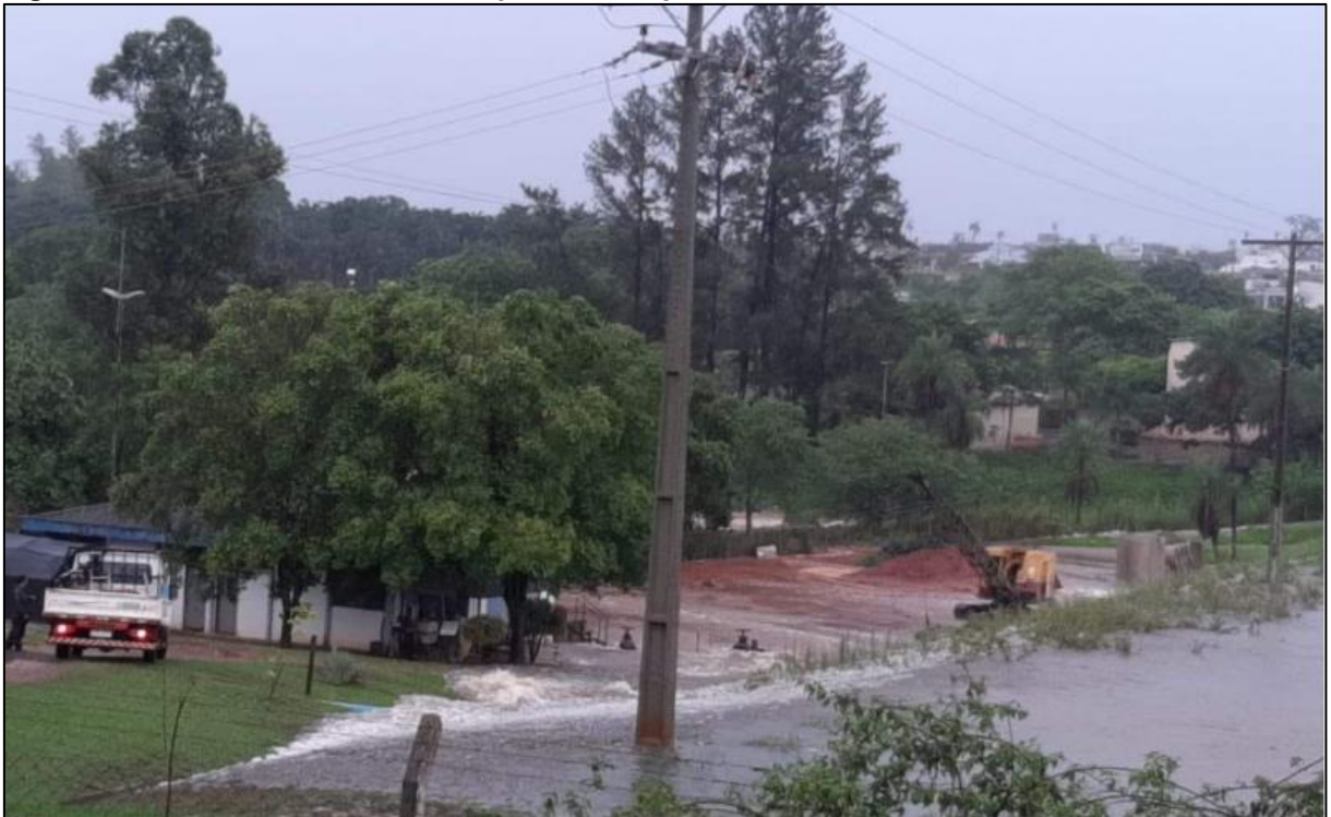
Figura 275: Transbordamento da Represa de Captação em 2022
