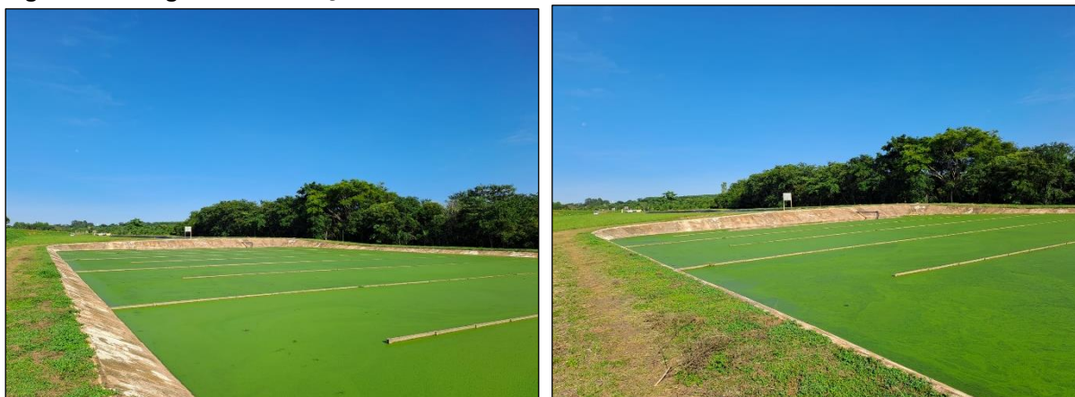
Figura 182: Lagoa de Maturação ETE Simonsen
