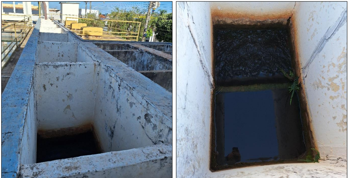
Figura 125 – Floculador de Chicanas Horizontais
