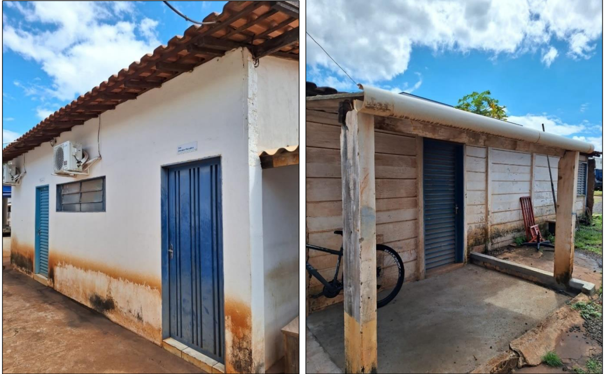
Figura 93: Casa de Descanso para Funcionários e Depósito de Cimento
