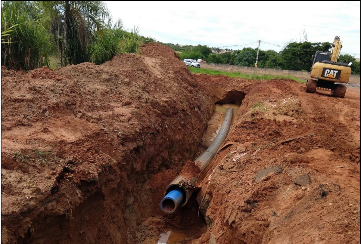
Figura 147 - Travessia Subterrânea (T-5) - Etapa de Execução Adutora ETA - Oeste
