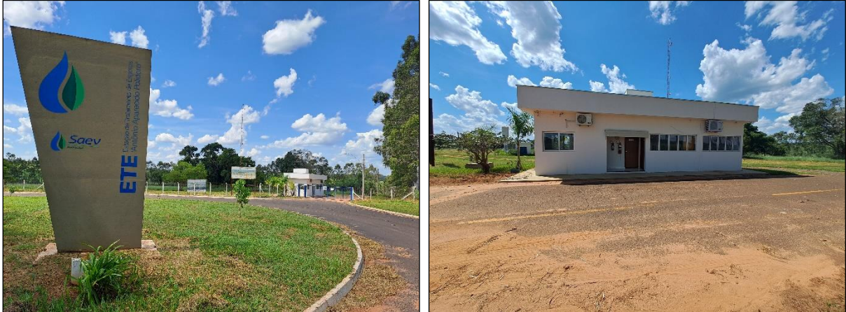
Figura 169: Vista da entrada e do laboratório bacteriológico ETE Votuporanga
