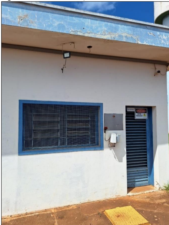
Figura 95: Casa de Força Sistema Sul
