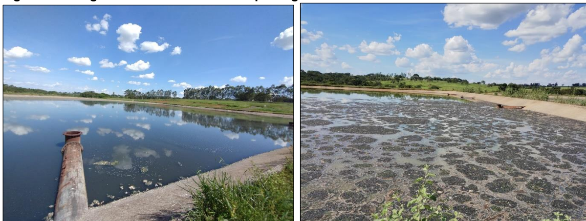
Figura 172: Lagoas Anaeróbias ETE Votuporanga
