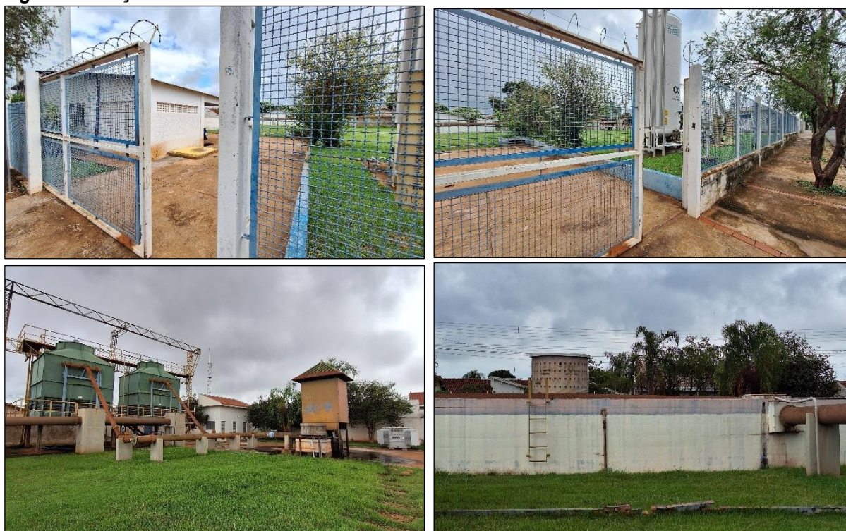
Figura 84: Poço Sistema Norte
