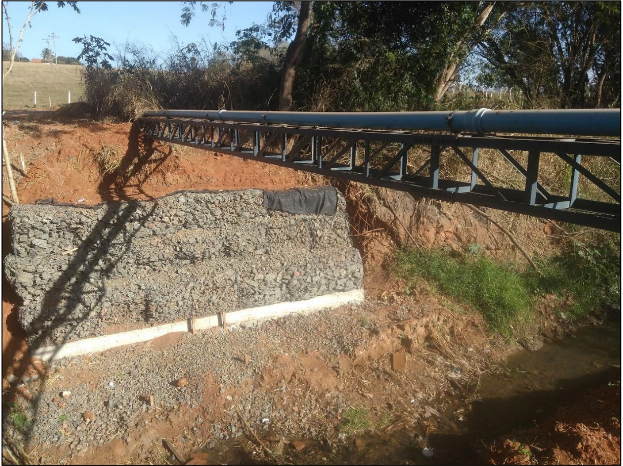
Figura 145 - Travessia Aérea (T-3) – CPVA
