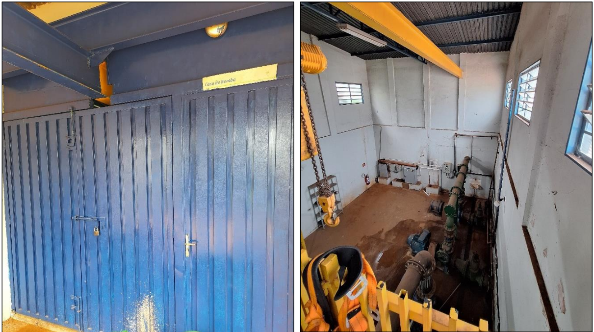
Figura 85: Casa de Bombas Sistema Norte
