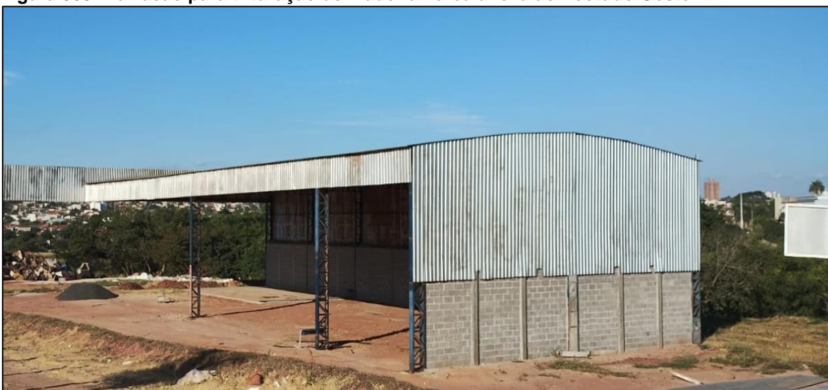
Figura 333: Barracão para trituração de madeira - área anexa ao Ecotudo Oeste
