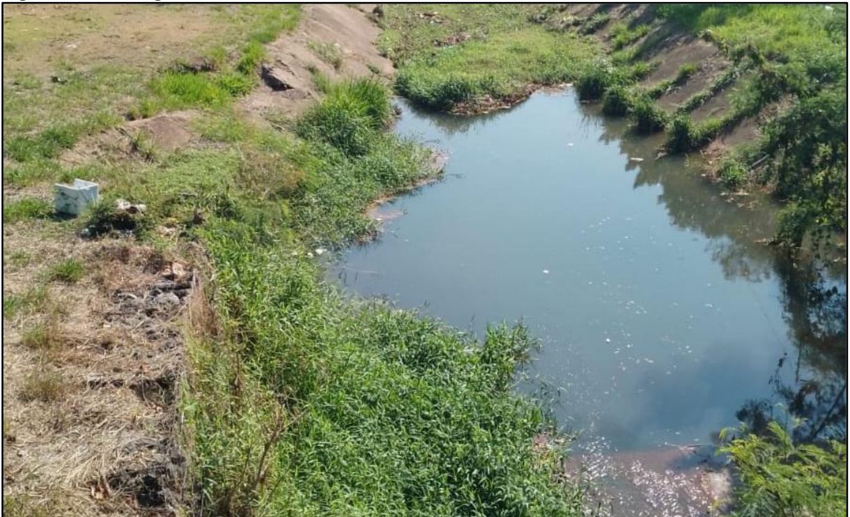
Figura 278: Córrego canalizado na rua Nelciades de Oliveira até Av. Conde Francisco Matarazzo
