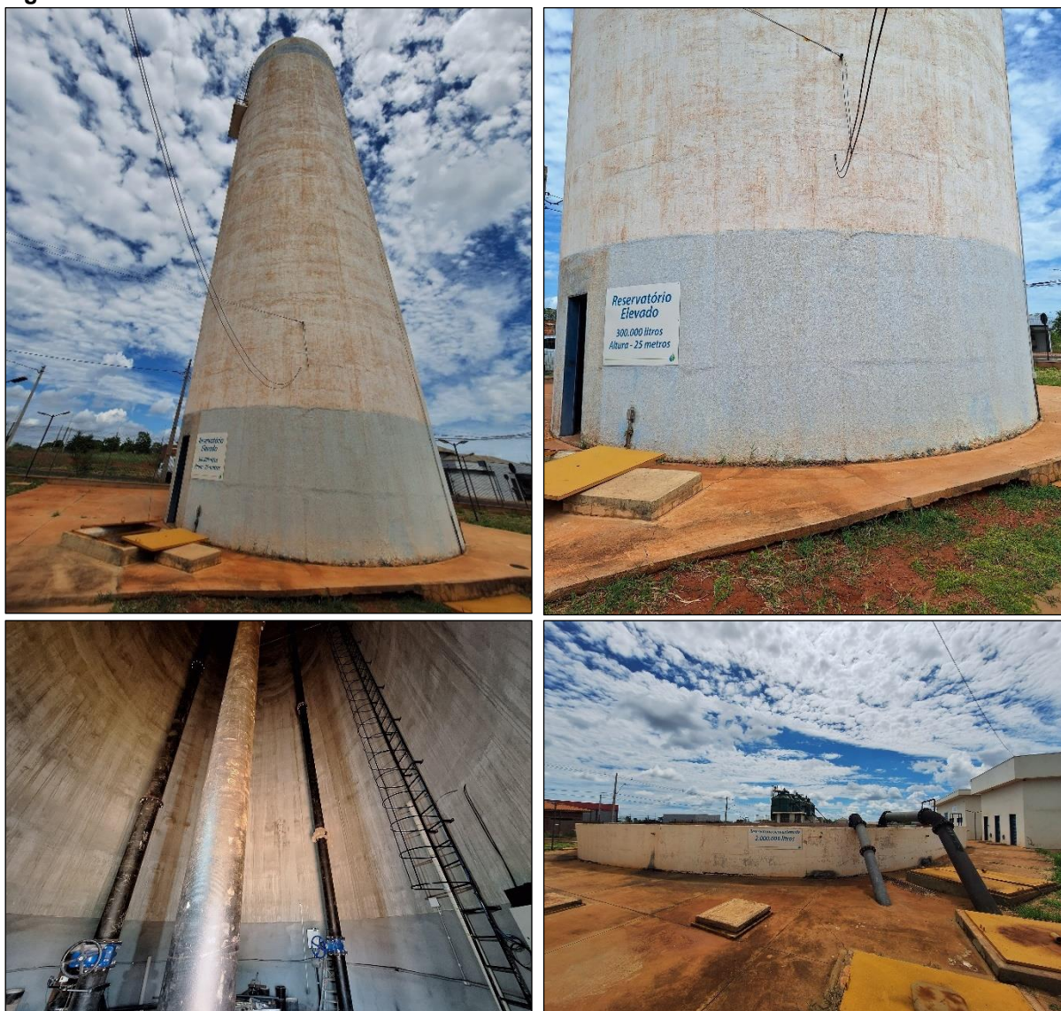
Figura 107: Reservatório Elevado Sistema Oeste
