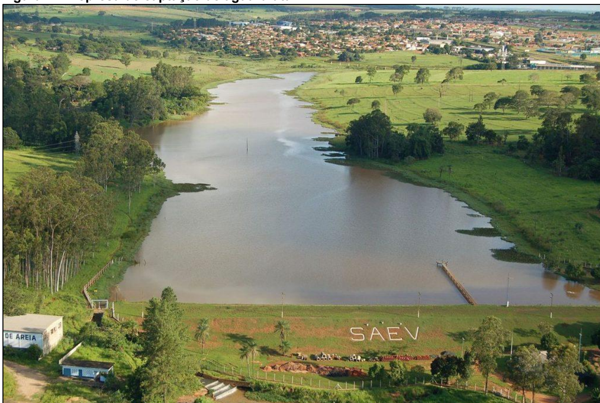
Figura 44: Represa de captação de água bruta
