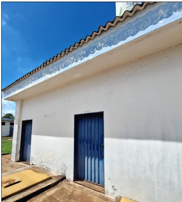
Figura 94: Casa de Bombas Sistema Sul
