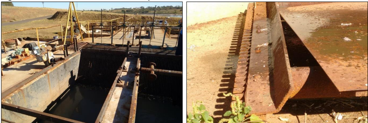
Figura 171: Grade rotativa do sistema preliminar
