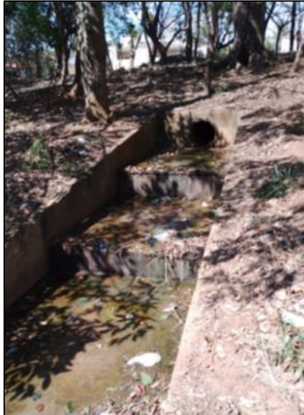
Figura 227: Dissipador de energia – Reserva Ambiental na rua Dante Furlani Colinas
