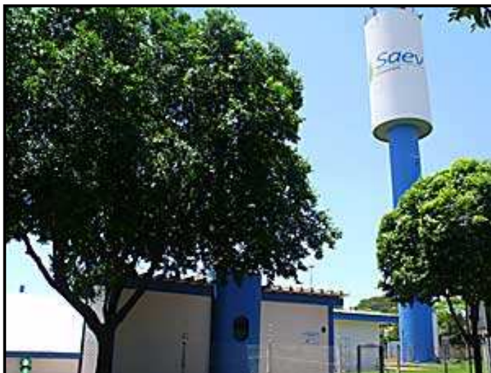
Foto 12: Reservatório Elevado - Poço Profundo Zona Sul/ Vila Muniz
