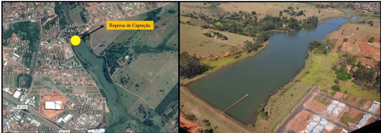
Foto 3: Fotos da Represa de Captação
