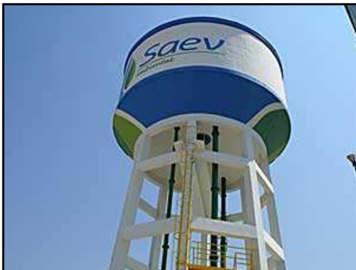
Foto 10: Reservatório Elevado- Estação de Tratamento de Água (ETA)
