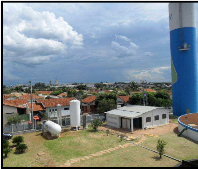
Foto 11: Reservatório Elevado - Poço Profundo Zona Norte
