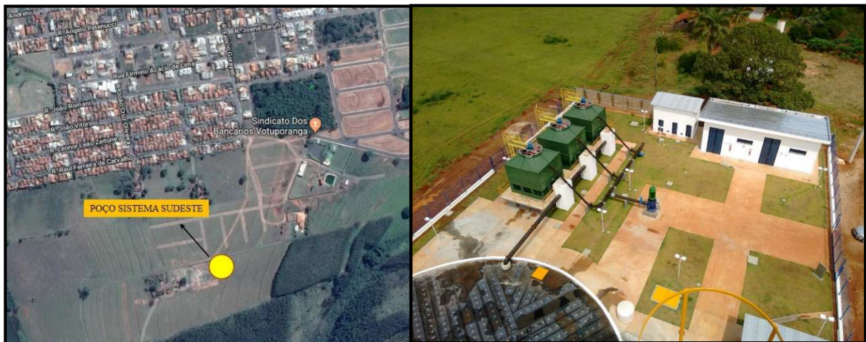
Foto 6: Imagem do poço profundo Zona Sudeste (2017)
