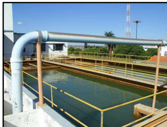
Foto 9: Represa de Captação do Córrego Marinheirinho e Tanque de Decantação - Estação de Tratamento de Água (ETA), área central do Município
