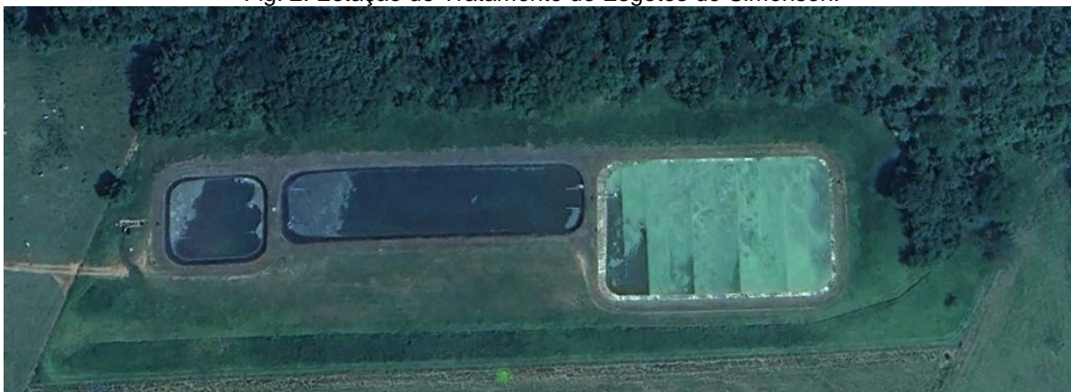
Fig. 2: Estação de Tratamento de Esgotos de Simonsen.
