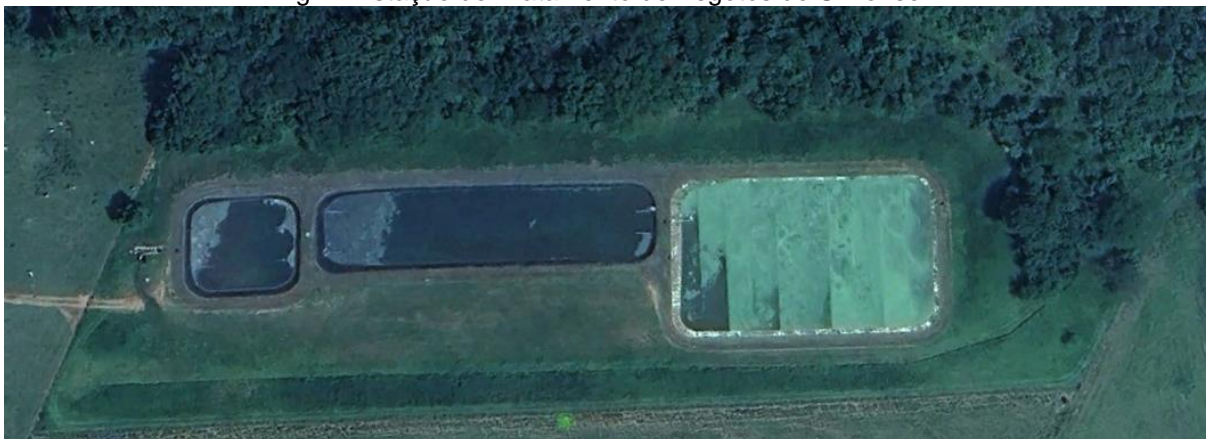
Fig. 4: Estação de Tratamento de Esgotos de Simonsen.
