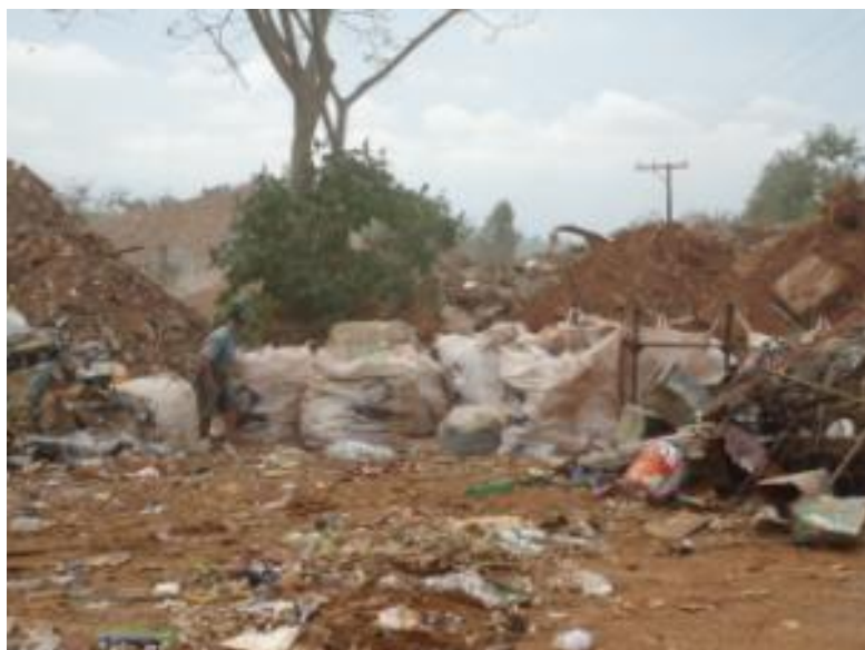
Figura 25 - Segregação de materiais em área de transbordo de RCC.
