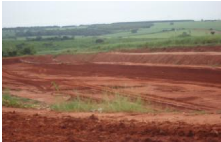
Figura 22 - Vista do aterro sanitário.
