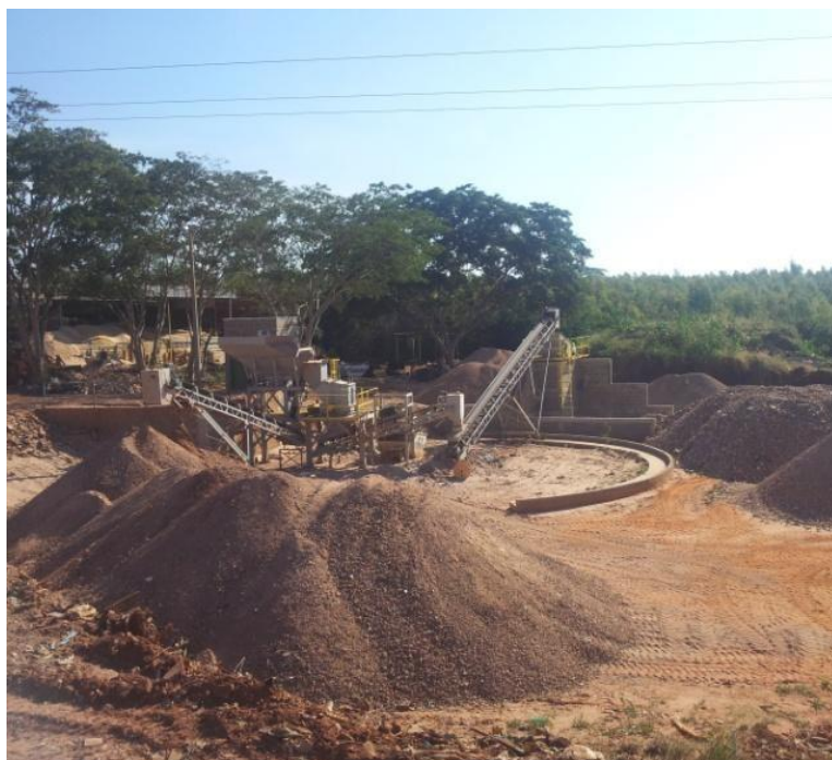
Figura 26 - Usina de reciclagem de entulho.
