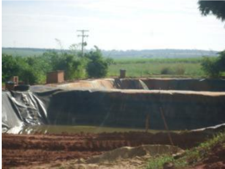
Figura 23 - lagoas de tratamento de chorume.
