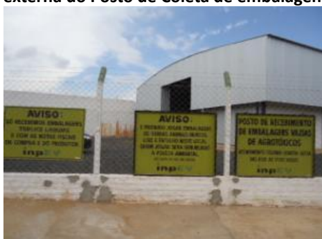
Figura 64: Vista externa do Posto de Coleta de embalagens de agrotóxicos.
