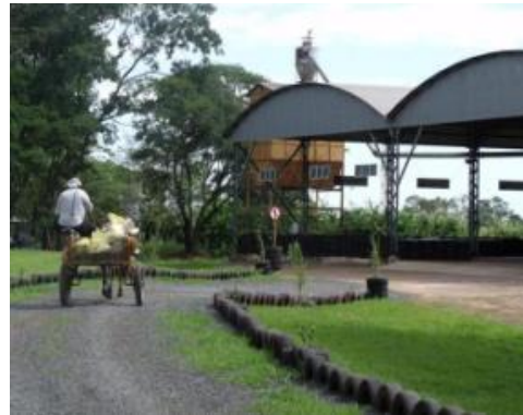
Vista geral do acesso ao barracão do ECOTUDO sul.
