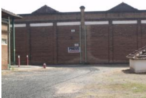
Figura 75: Vista geral ECOPONTO de pneus – ECOTUDO Sul.
