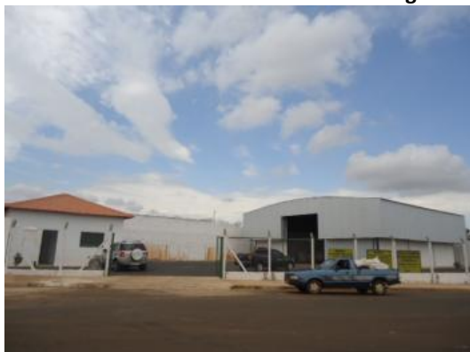
Figura 63: Vista externa do Posto de Coleta de embalagens de agrotóxicos.
