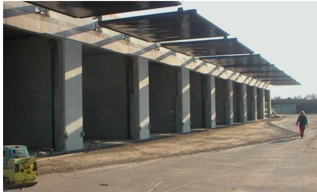
Figura 169: Túnel de compostagem intensiva.
