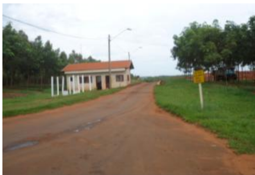
Entrada do aterro – guarita/balança.
