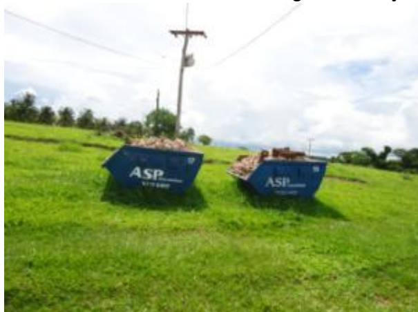
Figura 37: ATT – Área de transbordo e triagem - ASP caçambas.
