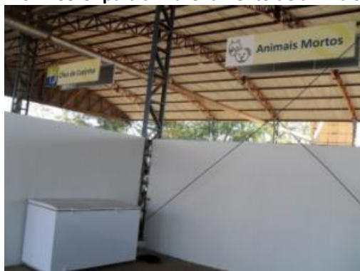
Figura 126: Freezer para armazenamento de animais mortos
