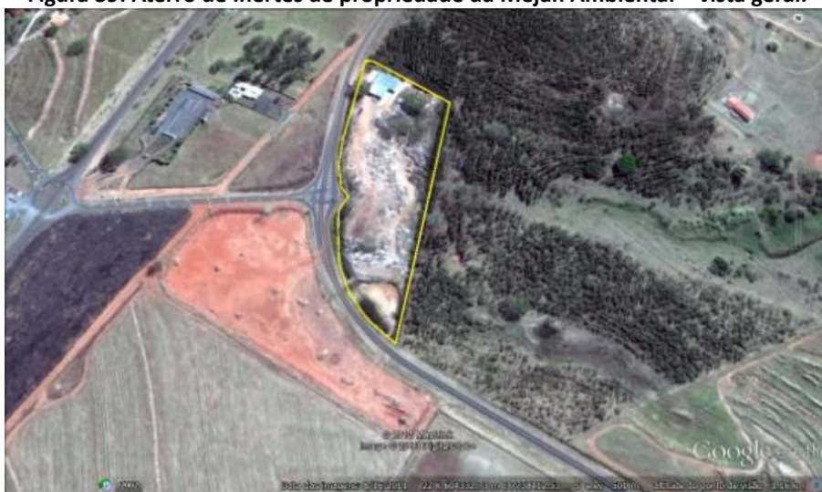
Figura 39: Aterro de Inertes de propriedade da Mejan Ambiental – vista geral.
