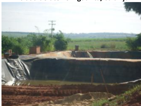
Lagoa de tratamento de chorume – aterro de Meridiano.
