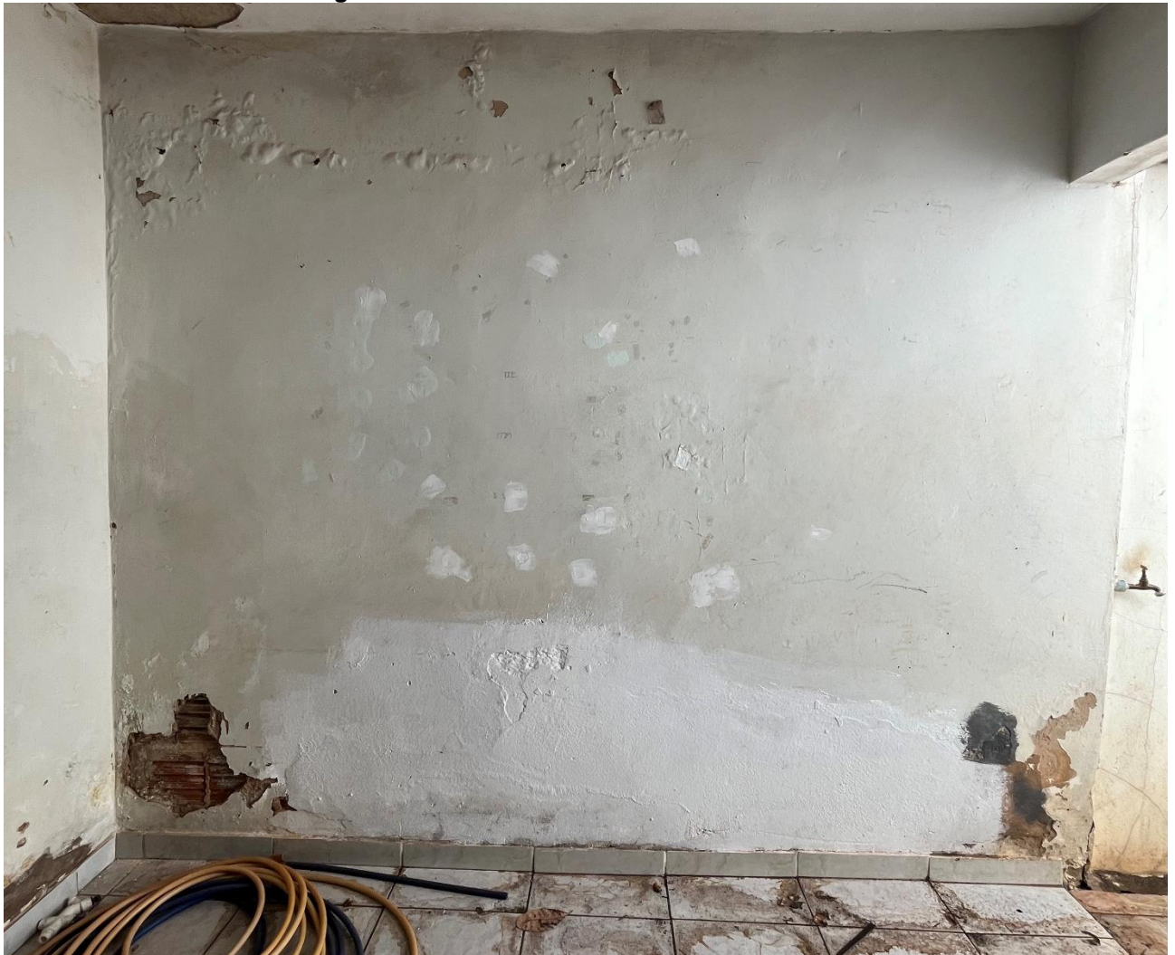
Figura 42: Parede Área externa – área a demolir
