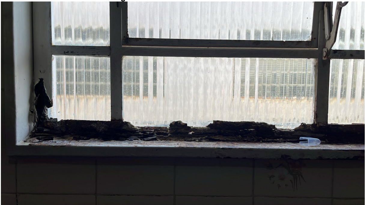
Figura 30: Janela do banheiro social
