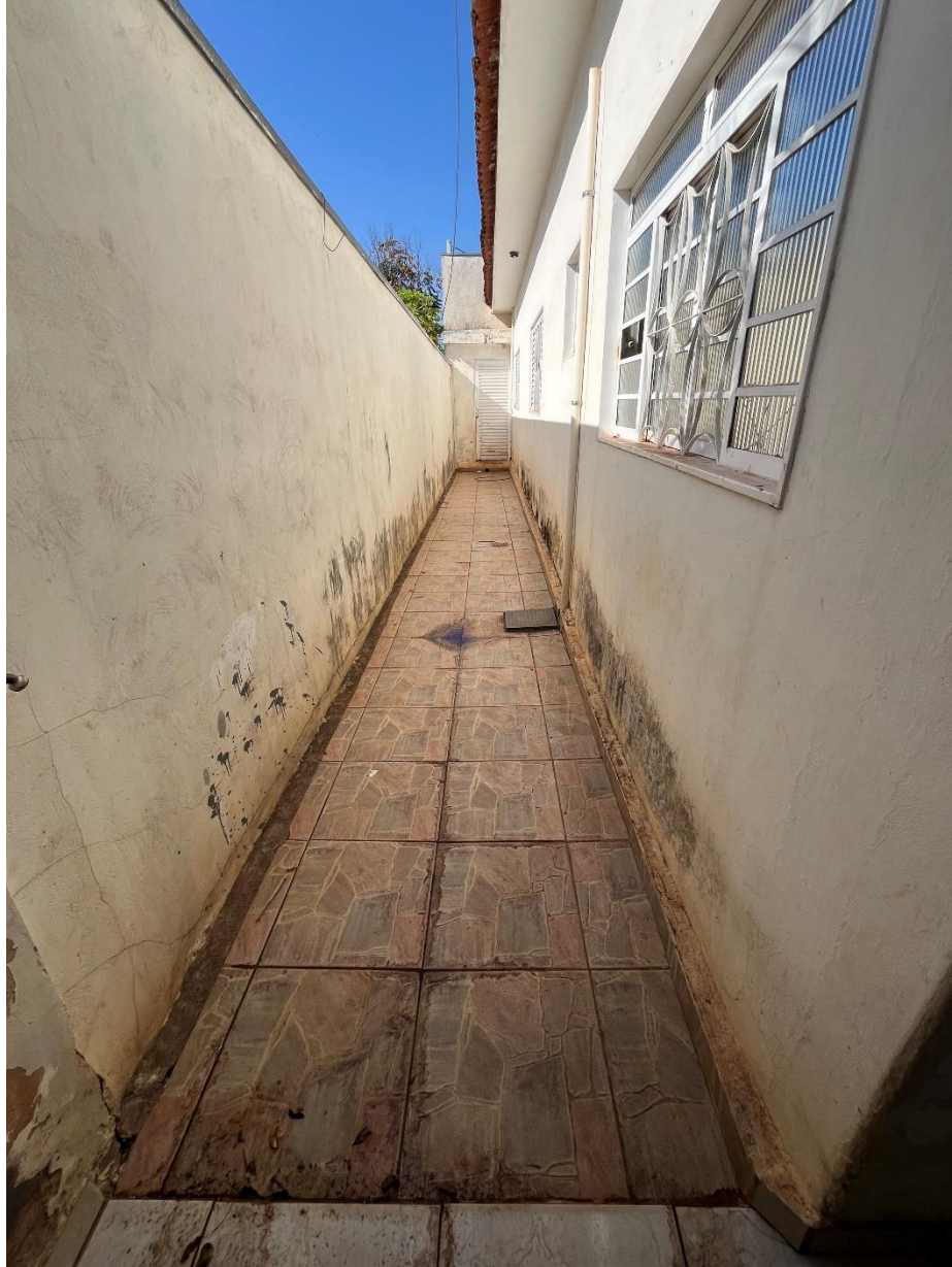
Figura 29: Corredor Lateral Direita
