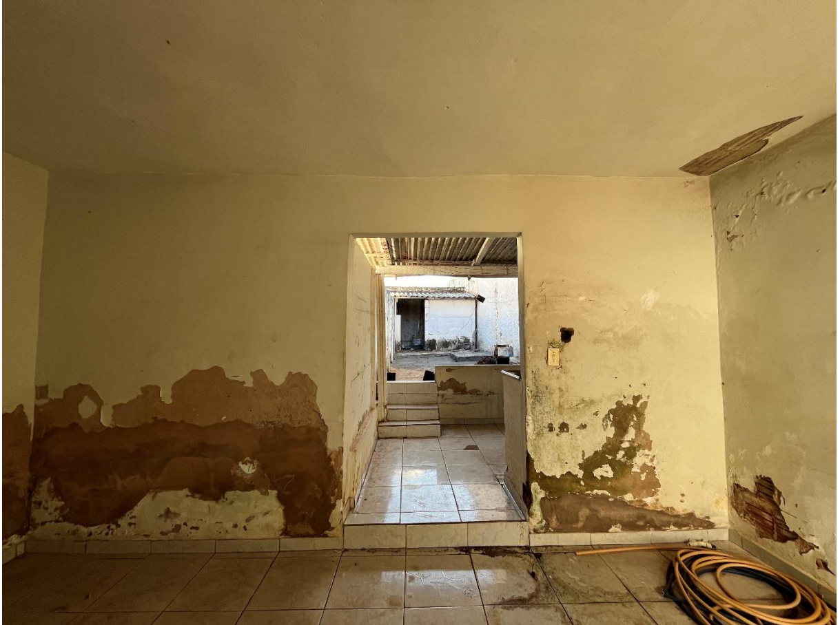
Figura 39: Parede Área externa – área a demolir
